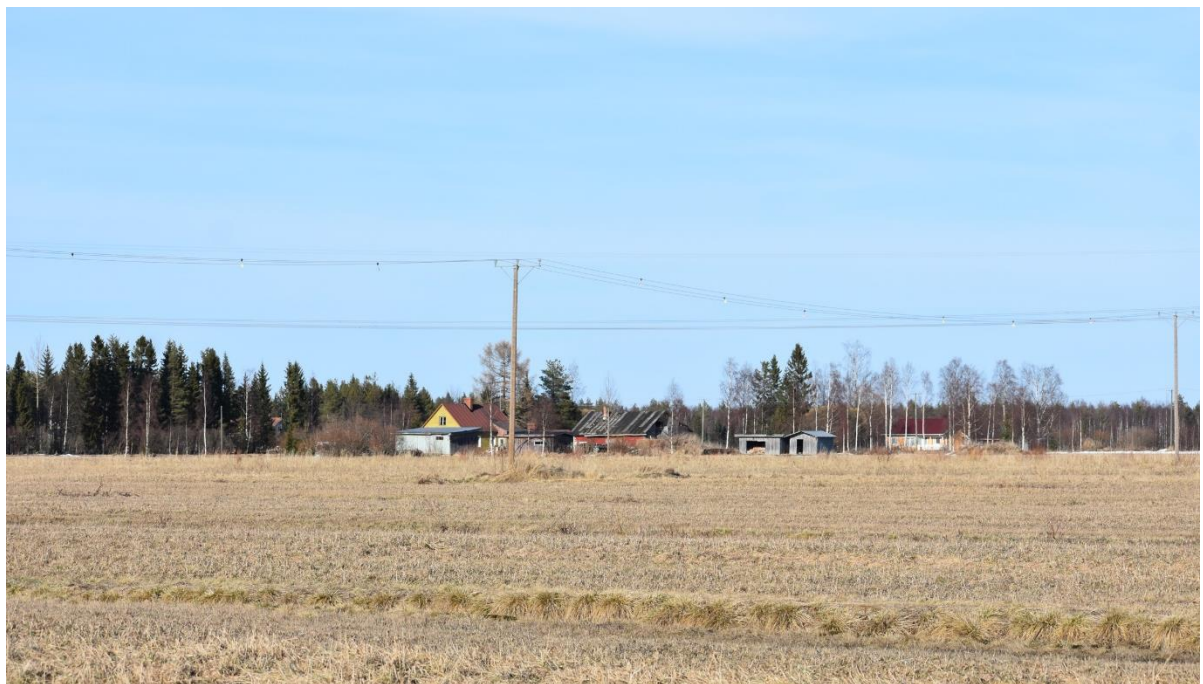
Kuva 12. Rajakorven peltoalueella on suurjännite- sekä matalajännitelinoissa lintujen törmäyksiä estäviä heijastimia ja palloja.
